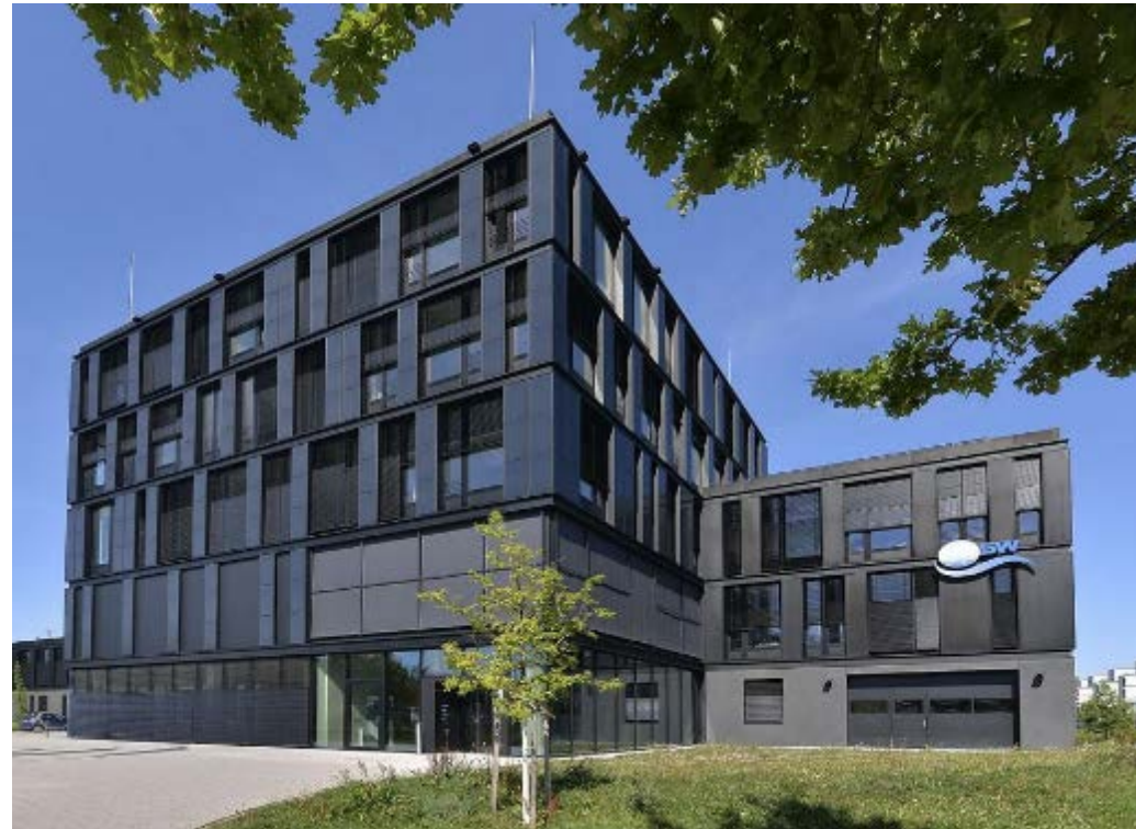
➤ ZSW-Gebäude in Stuttgart-Vaihingen (STEP) mit PV Fassade
